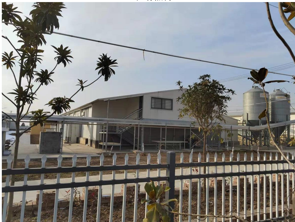
项目区建构物建设现状
